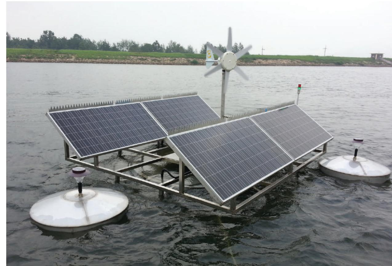
使用太阳能的预防绿藻生长水循环设备。
