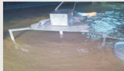
ECOCO Floating Mixing System是在污水、废水处理厂的无氧气槽、缺氧槽使用太阳能搅拌的设备。一台反应槽内放入大量的废水，无故障、无噪音。因使用太阳能，所以获得节能效果。采用浮力型设备，不论反应槽的深度，广泛使用的高效率、经济型搅拌设备。
